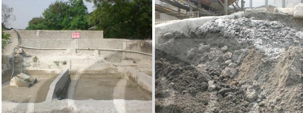
*Gambar 2.12 Bak penampungan limbah adukan beton dan limbah adukan beton*
