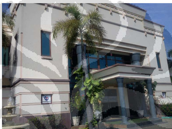
Gambar 4.4 Tampak Depan Gedung Redha PT Pacific Paint Sumber : Dokumentasi Penulis (2012)
