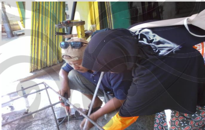
Gambar 6. Pengukuran Jarak Sumber Pengelasan dengan mata pekerja menggunakan meteran
