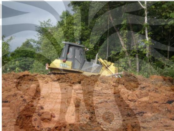
**Gambar 5.6 Proses *Land Clearing* Dengan Menggunakan D-85**
