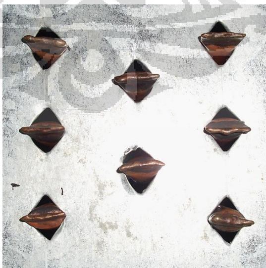
Gambar 3.5 Formasi *heat pipe* yang dipasang pada saluran udara
