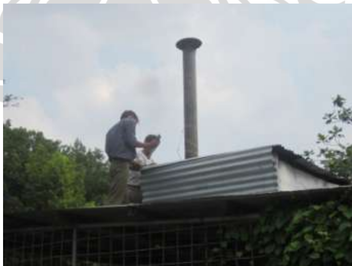
Gambar 3.18 Cerobong lama terpasang
