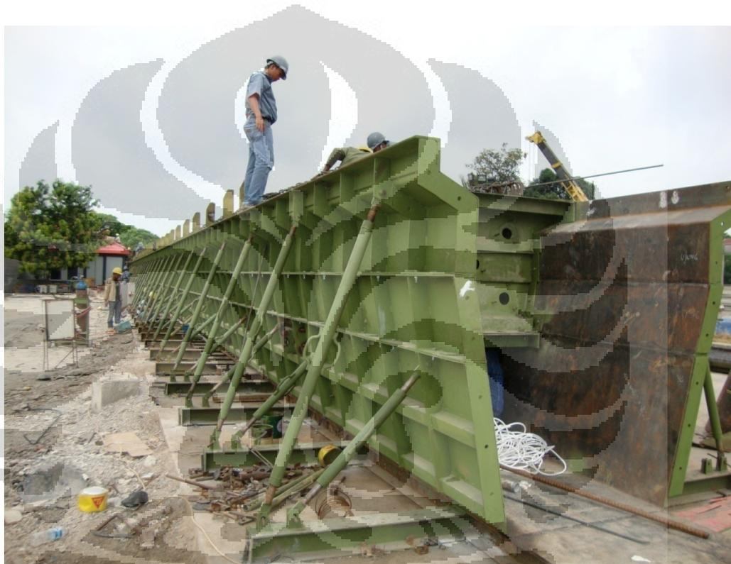
Gambar 5.3 Pemasangan cetakan PC-U girder
