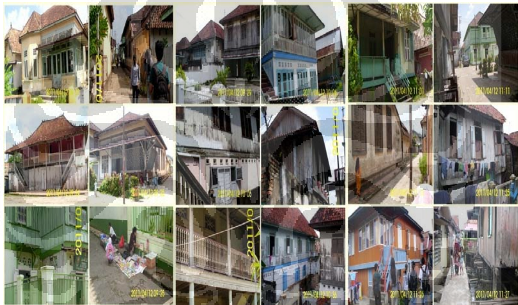
Gambar 4.8 Rumah-Rumah di Kampung Arab Palembang. [Sumber: Dokumen Pribadi]
