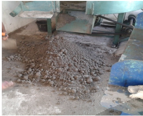
Gambar 13. Campuran Paving Block yang Telah Diaduk
