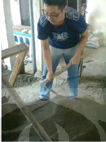
Gambar 4.5 Proses Penyaringan Pasir Daur Ulang Beton
