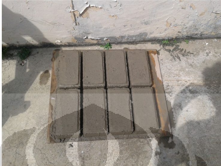
Gambar 4.13 Paving block yang telah selesai dicetak Untuk lebih lanjut, penulis melampirkan foto pembuatan paving block pada lampiran di gambar 12 – 18.
