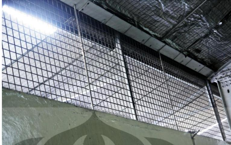
Foto 6. Celah di bagian dinding sekeliling gedung area produksi pelumas
