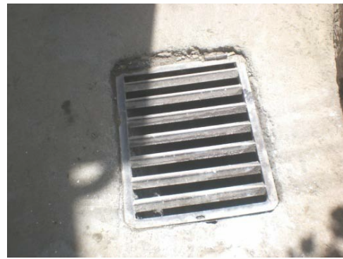
Gambar 4.7. Pembuatan Sumur Resapan
