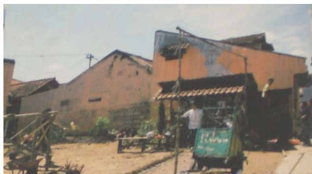
Gambar 4.1. Kondisi Kampung Sebelum Perbaikan
