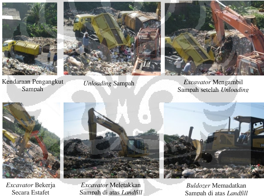
Gambar 4.3. Proses Penataan dan Penimbunan Sampah pada Landfill TPA Cipayung
