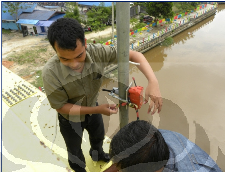
Gambar 4.3 Pemasangan geophone dan microtremor
