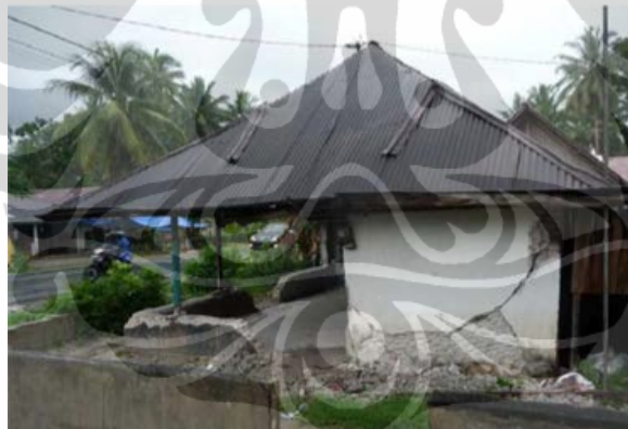
Gambar I.5. Contoh bangunan tanpa unsur penguat di Padang.
