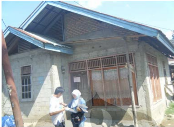
Gambar I.4. Contoh bangunan dengan unsur penguat di Padang.
