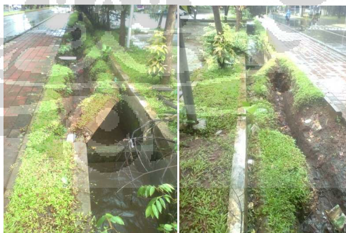
Gambar 2.27 Kelongsoran Saluran Drainase Depok, 2012: a. Foto Melintang Arah Barat, b. Foto Melintang Arah Timur
