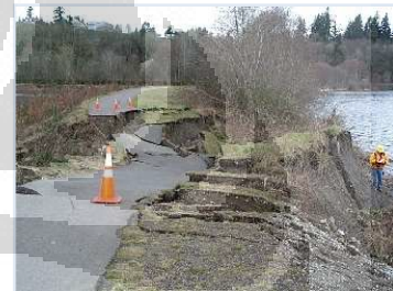
Gambar 2.17 Bentuk Longsoran Lateral Spreads beserta Contoh Kasusnya
