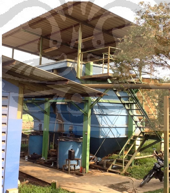
Gambar 2.21 Bak Overflow Lamela atau Bak Pengendapan
