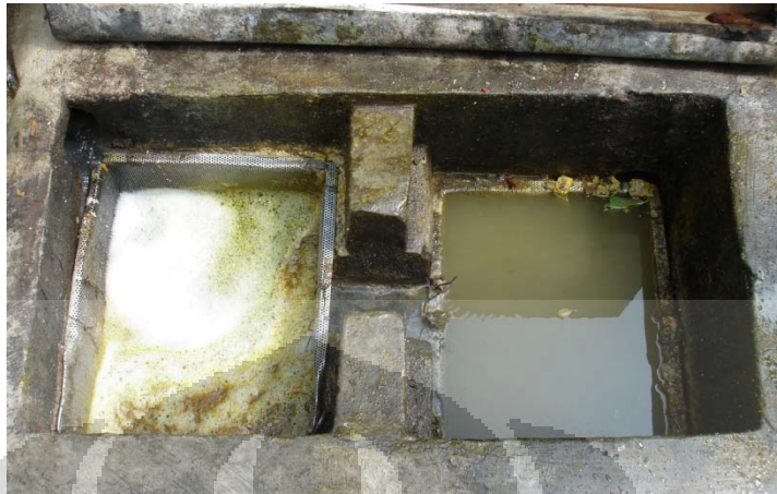
Gambar 4.2 Bak Pengumpul dan Penyaring Sementara Limbah Hasil Kegiatan Dapur
