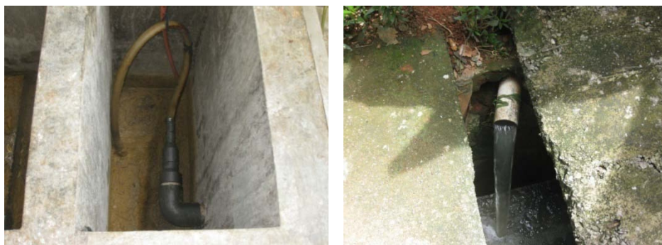
Gambar 4.12 Unit pemisah minyak dan lemak kompartemen 3 (kiri) hasil buangan menuju saluran kota (kanan)
