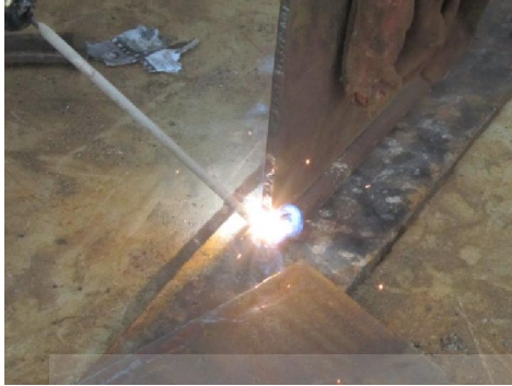
Gambar 3.12 Welding untuk Profil Bulb
