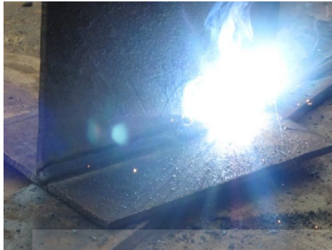
Gambar 3.8 Welding Untuk Profil T
