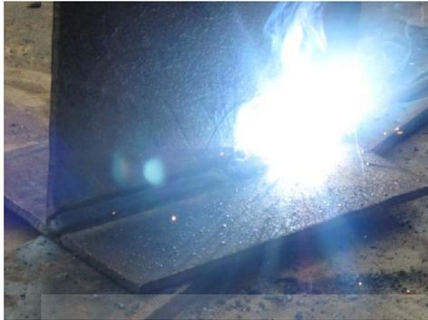
Gambar 3.8 Welding Untuk Profil T
