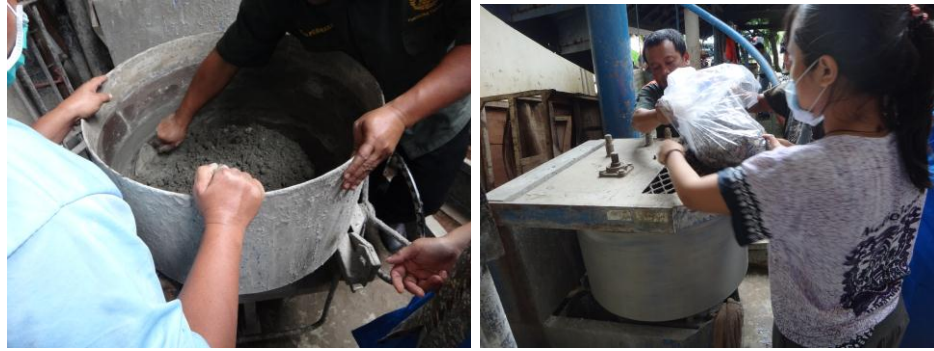
Gambar 4.6 Proses Pencampuran Beton
