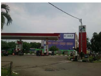
Foto 3. SPBU 34-16104 di Jalan Kedunghalang
