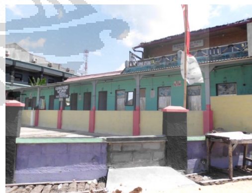
Foto 12: Toilet Umum di Jalan Pantai Barat (Januari, 2012)
