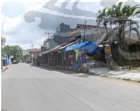
Foto 11: Alih Fungsi Trotoar di Jalan Kidang Pananjung (Januari, 2012)
