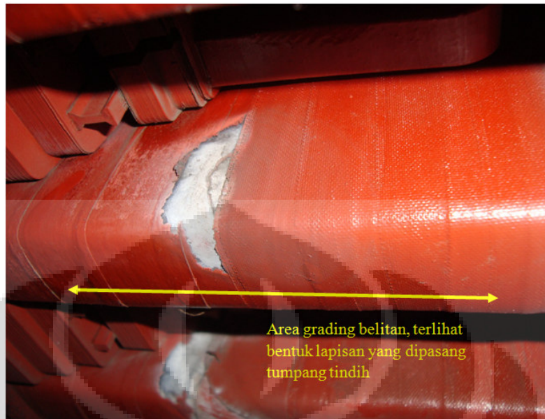
Gambar-4.11 Konstruksi Pemasangan Lapisan Konduktif dan Lapisan Semikonduktif Voltage Grading Generator Unit-4
