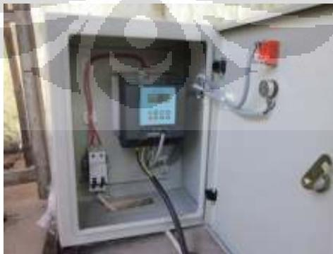
Gambar 3.10 *Control Panel 2* yang Digunakan untuk *Blower* Hisap (*Induced Draft Fan*)
