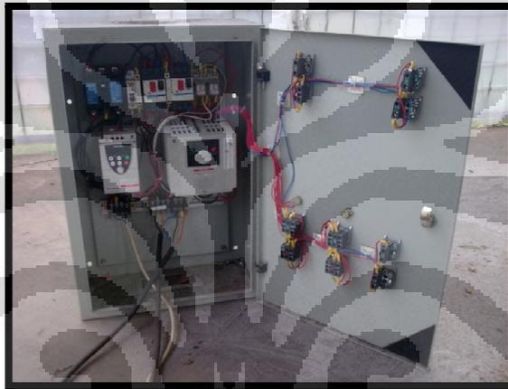
Gambar 3.9 *Control Panel 1* yang Digunakan untuk *Feeder* dan *Blower* Tiup (*Forced Draft Fan*)
