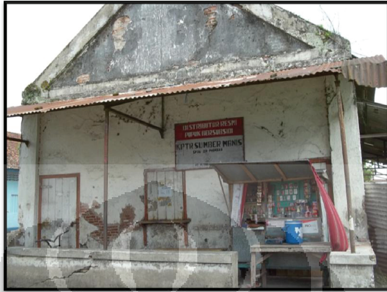
Foto 2.22 Bangunan rumah buruh. Sumber: Dokumentasi pribadi tahun 2011.
