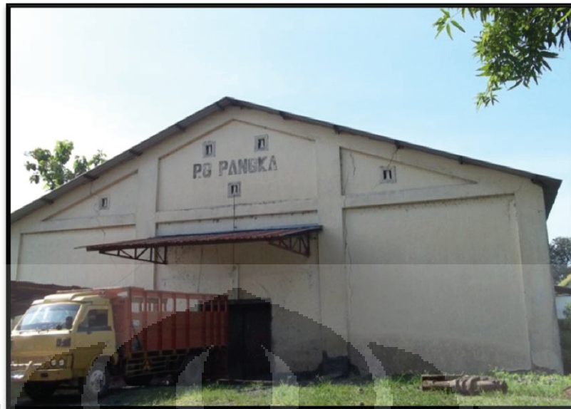
Foto 2.8. Bangunan B2, gudang pupuk. Foto tahun 2011.
