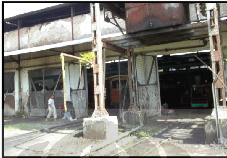
Foto 2.12. Bangunan C2 dilihat dari sisi selatan. Foto tahun 2011.
