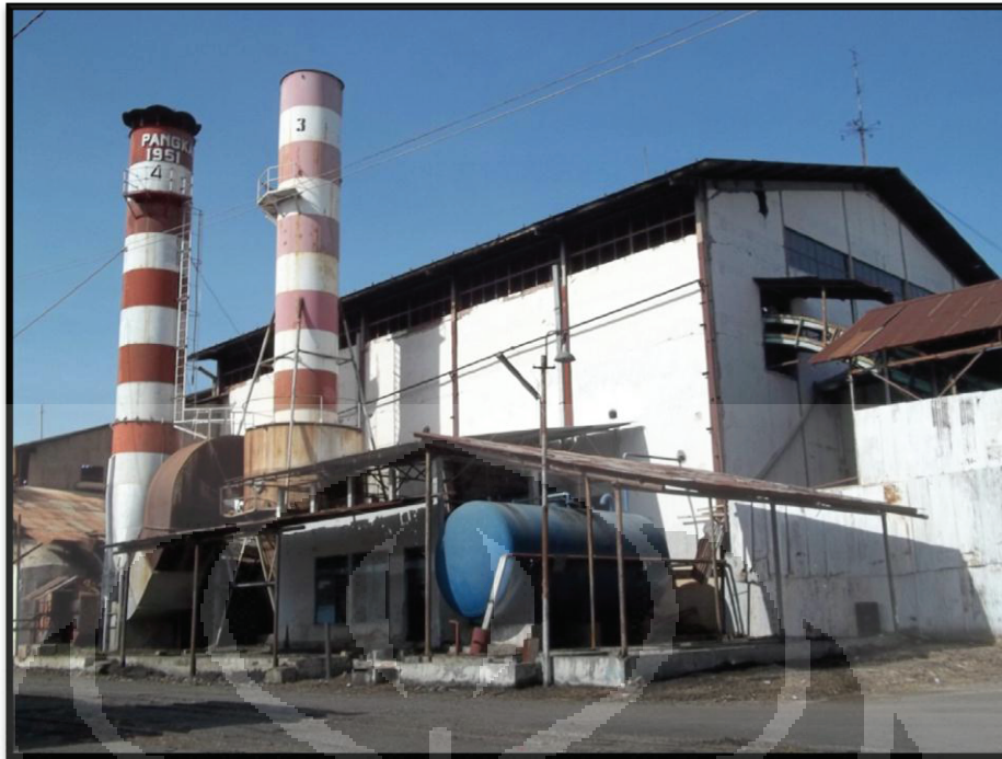
Foto 2.5. Bagian timur laut bangunan A. Foto tahun 2011.
