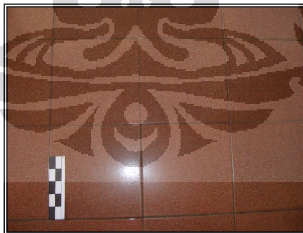
Gambar 2.11: Lantai Bagian Luar Bangunan Dok: Nabilah Zata Dini, 2012
