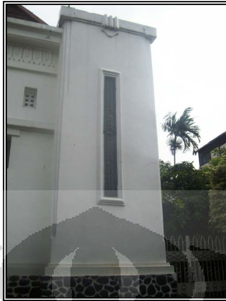
Gambar 2.72: Ruang Tangga Tampak Luar Dok: Nabilah Zata Dini, 2012
