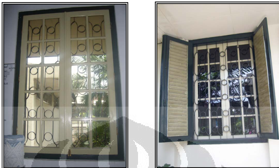
Gambar 2.65: Jendela Ruang Konsistori Dok: Nabilah Zata Dini, 2012
