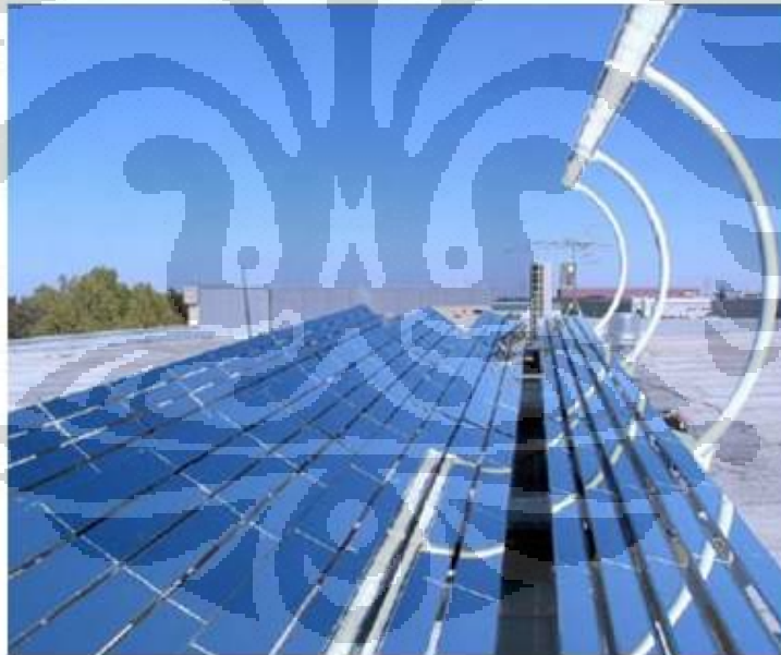
Gambar 2. 2 Hybrid solar cell dengan konsentrator parabola [2]
