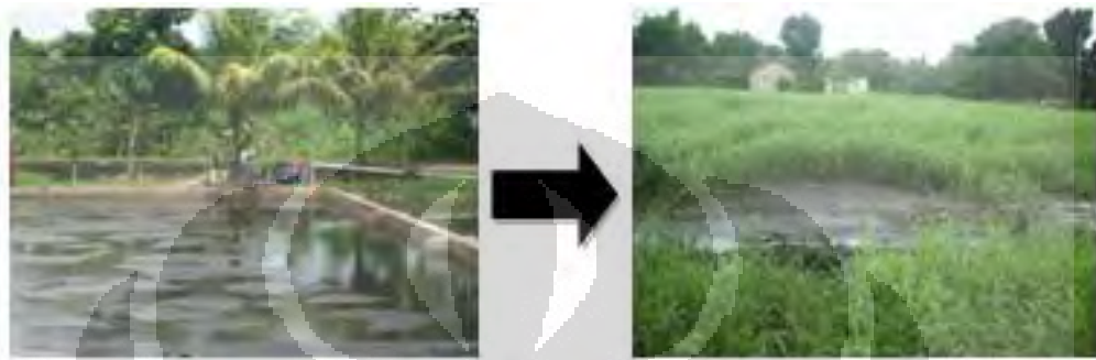
Gambar 4.4 Lumpur Tinja yang dibuang ke Sludge Drying Bed Sumber: Dokumentasi Penelitian, 2012
