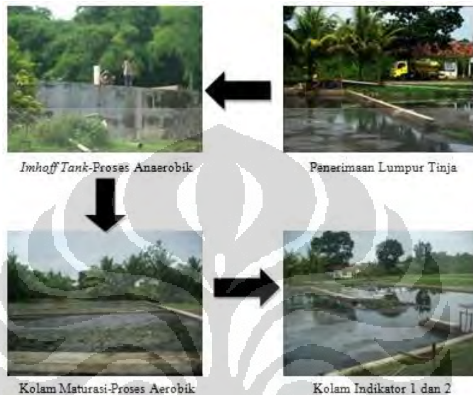
Gambar 4.2 Aliran Proses Pengolahan di IPLT Kalimulya Depok Sumber: Dokumentasi Penelitian, 2012
