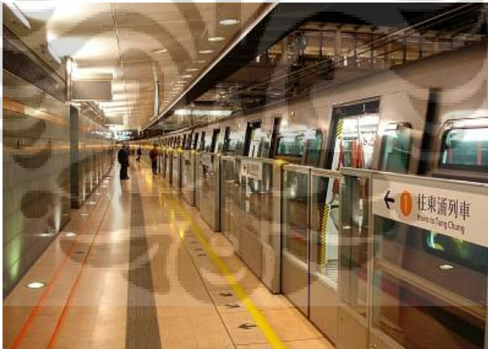
Gambar 2.10. PSD yang diintegrasikan pada stasiun bawah tanah Metro Sunny Bay, Hongkong
