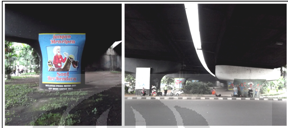
Gambar 3.6. Kondisi Fisik Ruang Bawah Jalan Layang Pancoran
