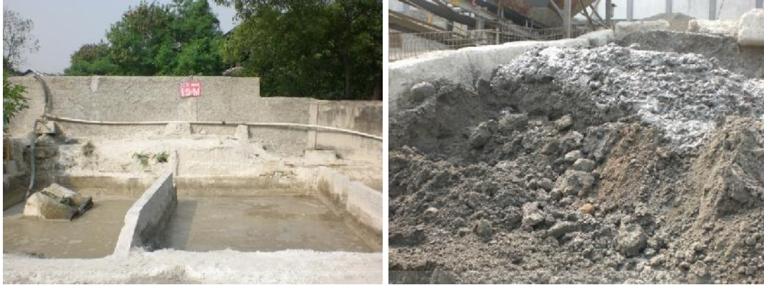
Gambar 2.2 Bak penampungan limbah adukan beton masih berupa lumpur.
