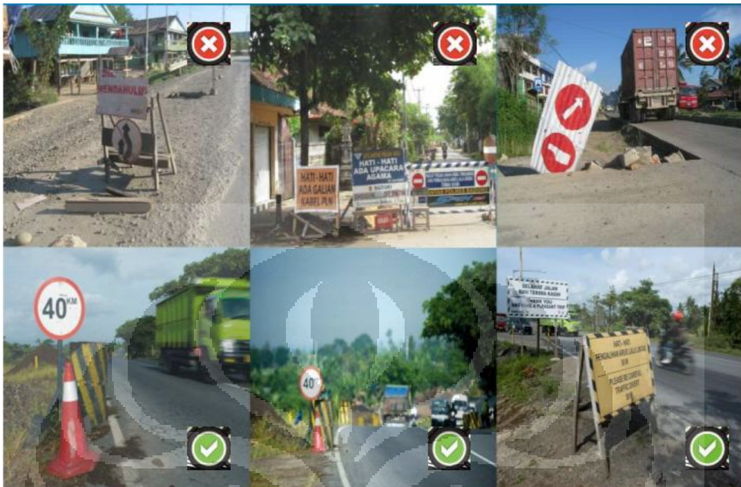
Gambar 2.8 Peletakan Rambu Jalan yang Tidak Memadai dan yang Sesuai Jarak Pandang
