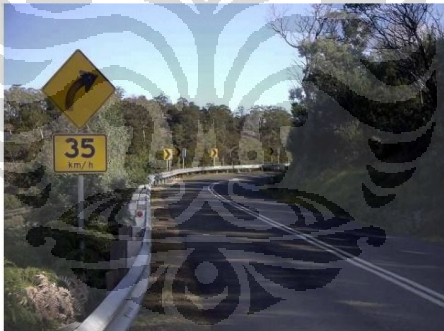
Gambar 2.18 Penggunaan Marka Garis Solid dan Delineasi yang baik
