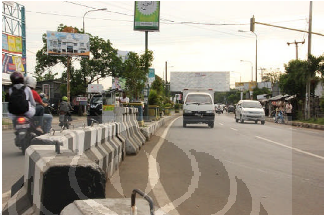
Gambar 4.5 Kondisi Arus Lalu Lintas Ruas Jalan Raya Jendral Sudirman
