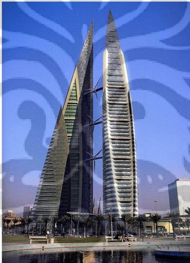
Gambar 4.2. Fasad Bangunan dilapisi dengan material yang dapat menahan radiasi panas matahari dan shading bangunan yang bermanfaat untuk menurunkan temperatur udara dalam bangunan Sumber :
