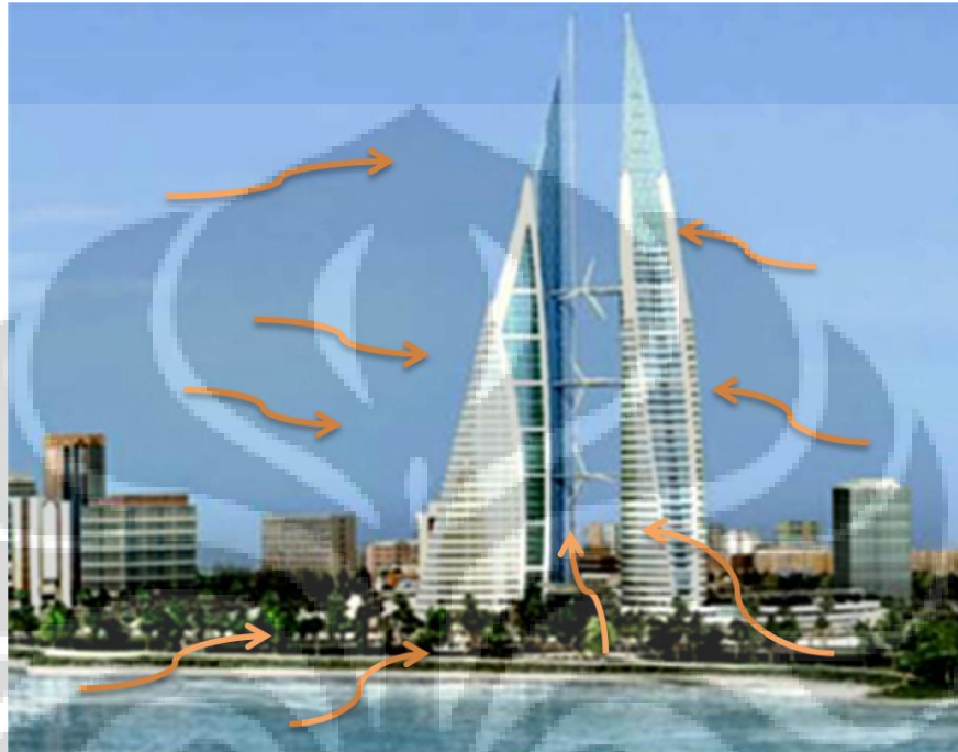
Gambar 4.5. Arah angin dari teluk. Pada siang hari angin datang dari teluk dan dari pergerakan kendaraan di jalan yang berada di depan WTC Bahrain, turbin angin berputar lebih konstan
