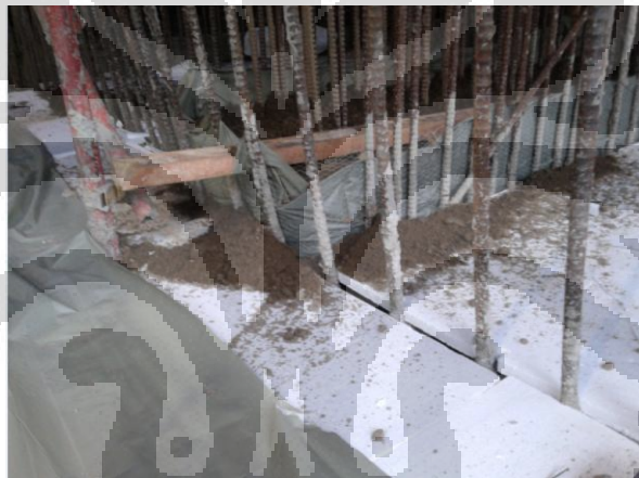
Lapisan Insulasi (3 lapis Styrofoam + plastik)
