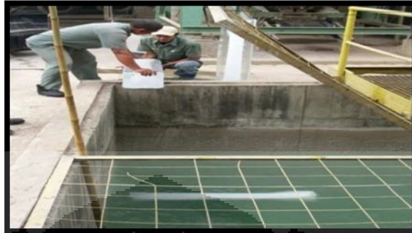
Gambar 2.10. Pendinginan air pencampur
