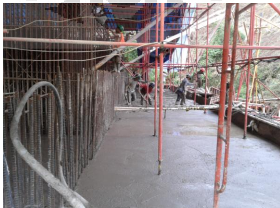
Pengecoran menerus (tanpa pour delay )
