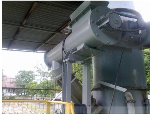
Gambar 3.10 Sistem feeder pada fluidized bed combustor UI
