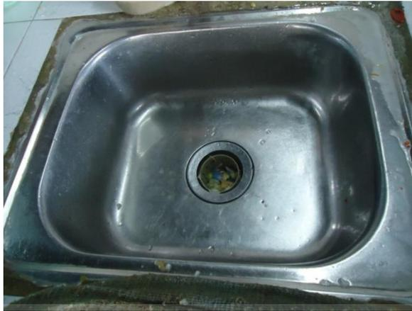
Gambar 4.4 Saringan Bak Cuci di Kantin FTUI
