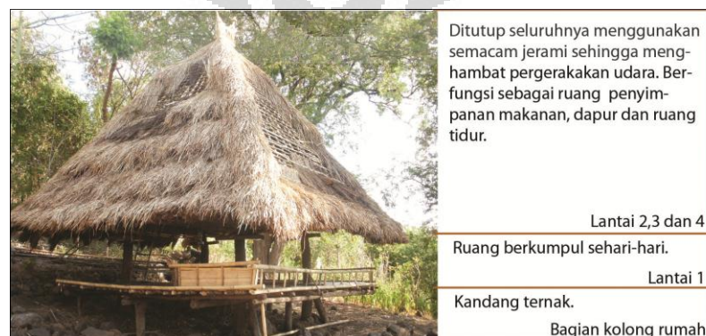
Gambar 3.2. Rumah Fala dalam tahap pembangunan.
