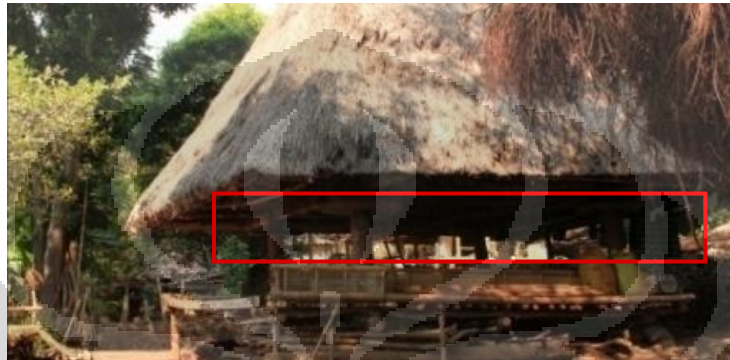
Gambar 2.3. Penghalang tikus pada rumah Fala. Rumah adat Alor, bagian yang ditandai adalah lokasi fala yaitu lingkaran untuk menghalangi tikus masuk. (sumber: Alor Living Celebration )
