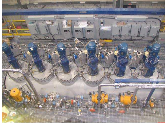
Gambar 2.7 Autoclave untuk Pressure Leaching [10] .
