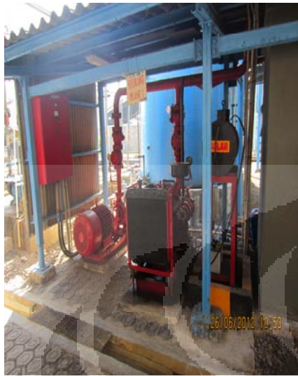
Gambar 9. Pompa Pemadam
