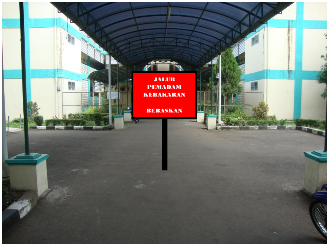
Gambar 7.19 Pemasangan Penandaan Akses Pemadam ke Lingkungan Gedung
