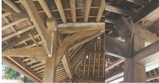
Gambar 44 Struktur Konstruksi Atap pada Blandongan (Dok. Peneliti, 2010)
