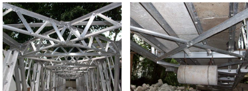
Gambar D.3. Pengaku Diagonal Rangka Atas (kiri) dan Modelisasi Beban Truk (kanan)
