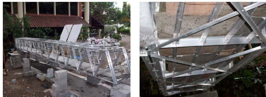
Gambar D.2. Tampak Jembatan (kiri) dan Bagian Bawah Jembatan (kanan)
