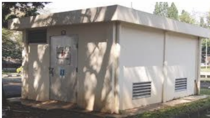
Gambar 2. 4 Konstruksi Gardu Beton
