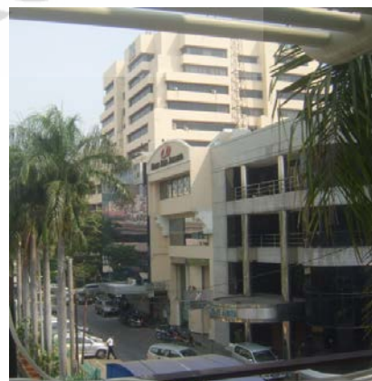
Gambar 5.2 ITC Mangga Dua yang terlihat dari samping
