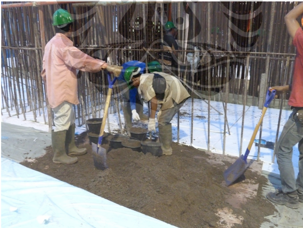
Insulasi dengan Pasir pada Area Kolom dan Rib Beam
