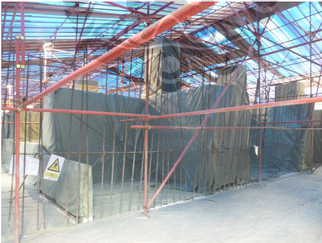
Penutupan Kolom dan Rib Beam dengan Plastik
