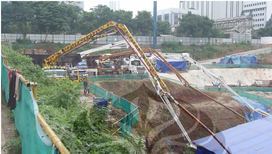
Concrete Pump pada Pengecoran Raft Foundation Rasuna Tower
