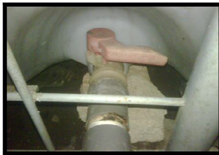
Gambar 3.9 Sistem bukaan tangki air
