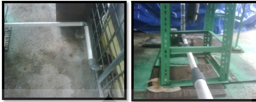
Gambar 3.6 Sistem pemipaan keluar tangki
