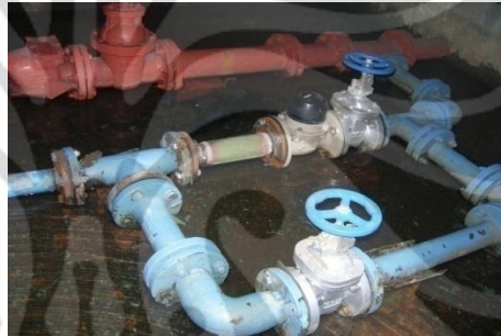
Gambar 6.1: Percabangan pipa utama dengan pipa gedung
