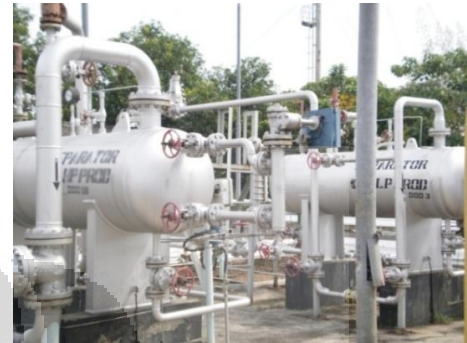
Gambar 6.5 Separator LP SP Pasir Jadi (Kanan)
