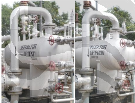
Separator HP Prod & Test SP PSJ
