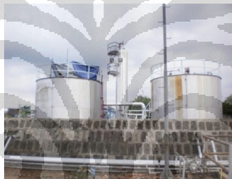
Gambar 6.6 Tangki Penyimpanan Kondensat SP Pasir Jadi
