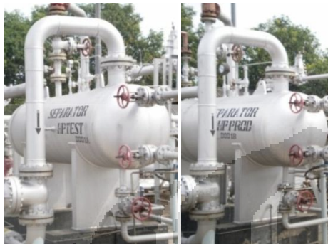
Gambar 6.4 Separator HP Test dan Prod. SP Pasir Jadi
