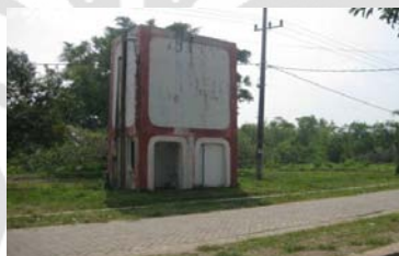
Bangunan tandon sebagai suplai bersih warga.
