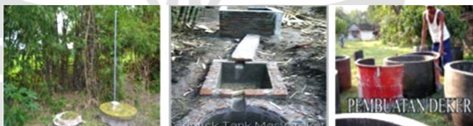
Gambar : 5.3 Pembangunan WC Permanen Menggunakan Deker
