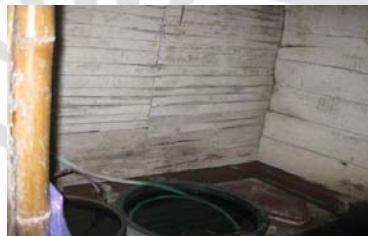
Bangunan WC warga yang dibangun secara swadaya.
