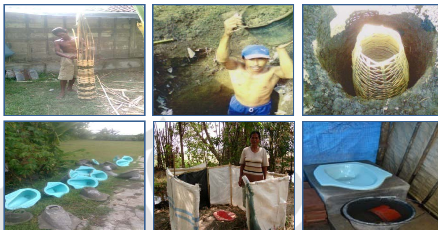
Gambar : 5.2 Pembangunan WC Menggunakan Srumbung
