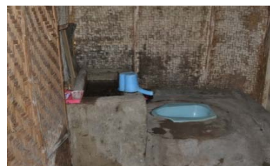
Bangunan WC masyarakat yang dibangun secara swadaya.
